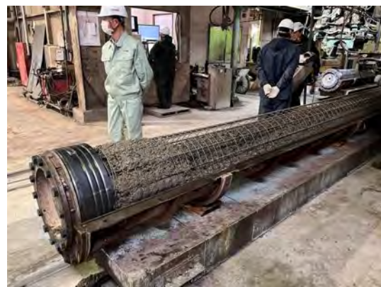
鉄筋コンクリート杭 コンクリート打設後
