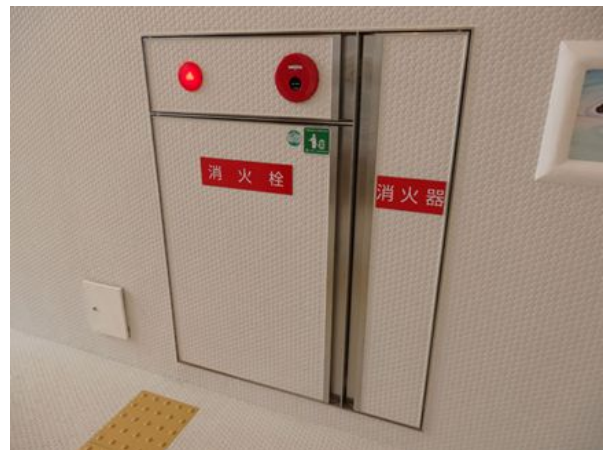
屋内消火栓もモザイクタイル
