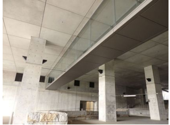
渡り廊下 30mを超えるこの廊下の構造は・・・？
